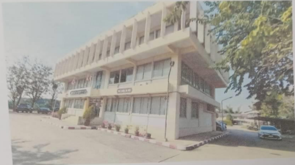
ก่อนดำเนินการตามโครงการลดความร้อนและประหยัดพลังงาน
